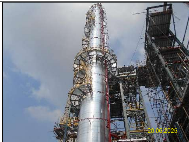
จ) กิจกรรมการติดตั้งหอแยกก๊าซโพรเพน (New DePropanizer Column) และระบบหล่อเย็นแบบ Air Cool
